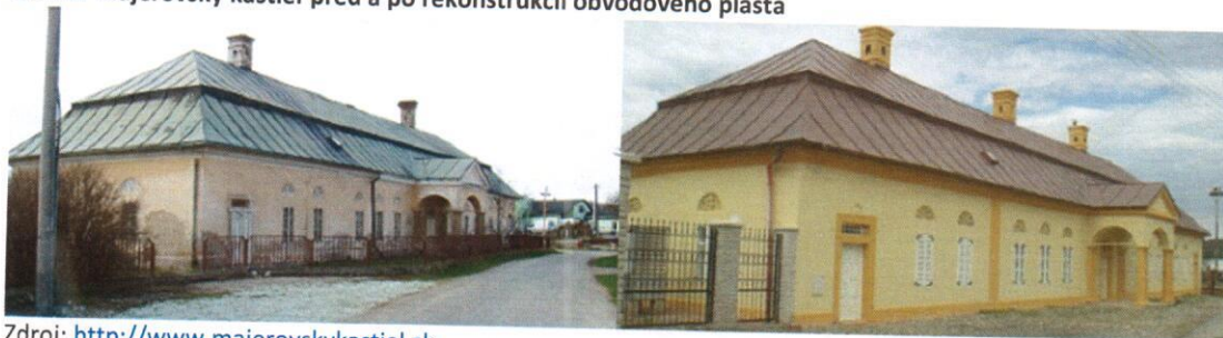
Obr. 1: Majerovský kaštieľ pred a po rekonštrukcii obvodového plášťa
